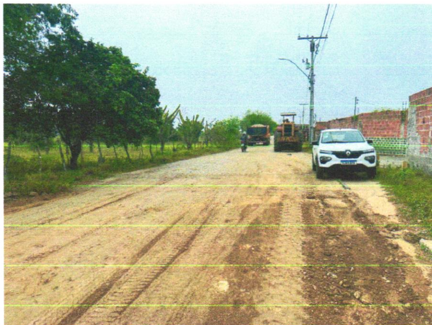
Foto 06 - TRANSPORTE COM CAMINHÃO BASCULANTE DE 6 M 3 , EM VIA URBANA EM LEITO NATURAL (UNIDADE: M3XKM). AF_07/2020
