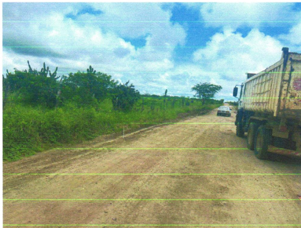
Foto 05 - TRANSPORTE COM CAMINHÃO BASCULANTE DE 6 M 3 , EM VIA URBANA EM LEITO NATURAL (UNIDADE: M3XKM). AF_07/2020
