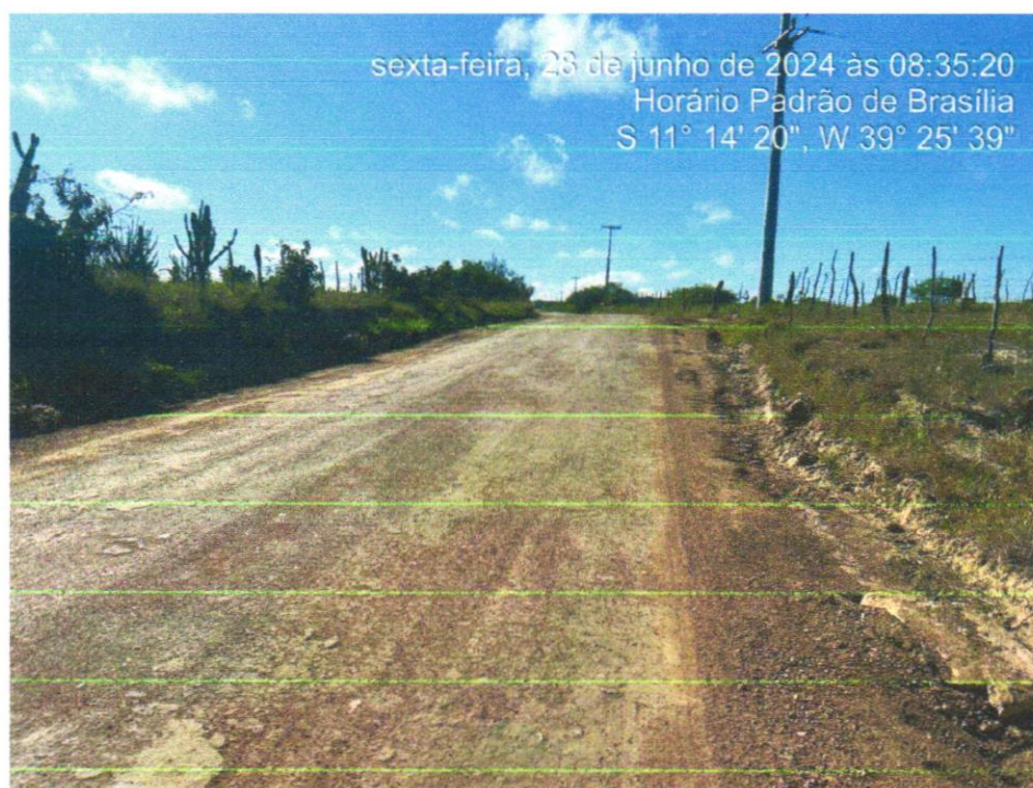
Foto 01 - REGULARIZAÇÃO DE SUPERFÍCIES COM MOTONIVELADORA. AF_11/2019
