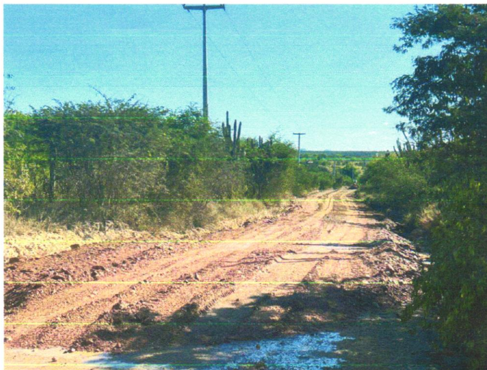
Foto 07 - EXECUÇÃO E COMPACTAÇÃO DE ATERRO COM SOLO PREDOMINANTEMENTE ARGILOSO - EXCLUSIVE SOLO, ESCAVAÇÃO, CARGA E TRANSPORTE. AF_11/2019
