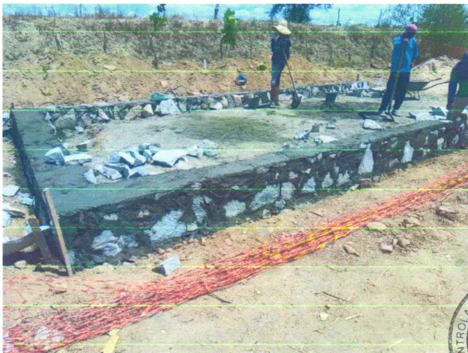
Foto 12 - MURO DE ARRIMO DE ALVENARIA DE PEDRA ARGAMASSADA
