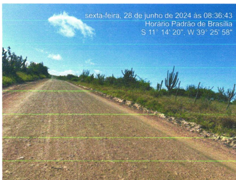
Foto 02 - REGULARIZAÇÃO DE SUPERFÍCIES COM MOTONIVELADORA. AF_11/2019
